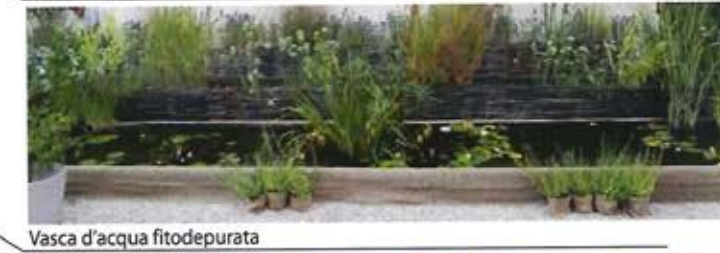
Vasca d'acqua fitodepurata
