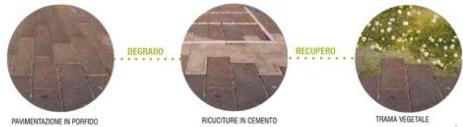
PAVIMENTAZIONE IN PORFIDO DEGRADO RECUPERO TRAMA VEGETALE
